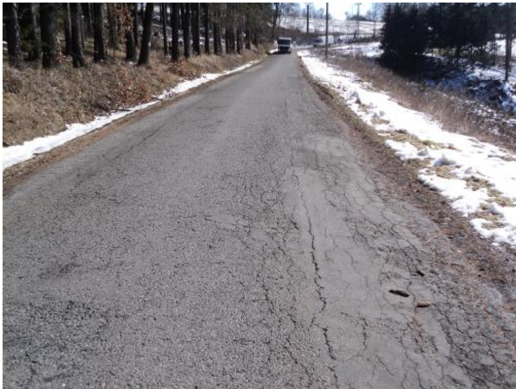
Plošná deformace vozovky, olamování okrajů vozovky – km 4,750.
