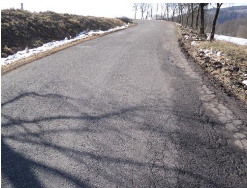
Síťové trhliny, olamování okrajů vozovky – km 3,350.
