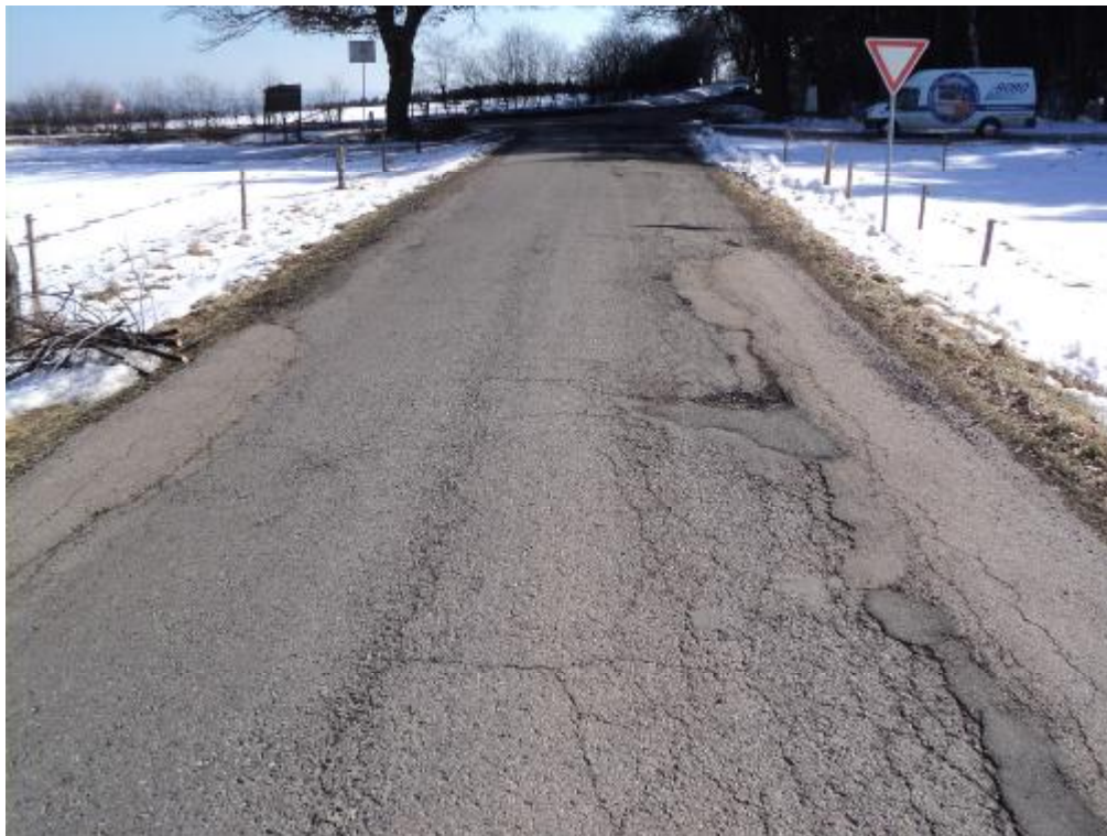
Plošná def. vozovky, vysprávký, výtluky v obr. vrstvě a krytu – km 7,450.
