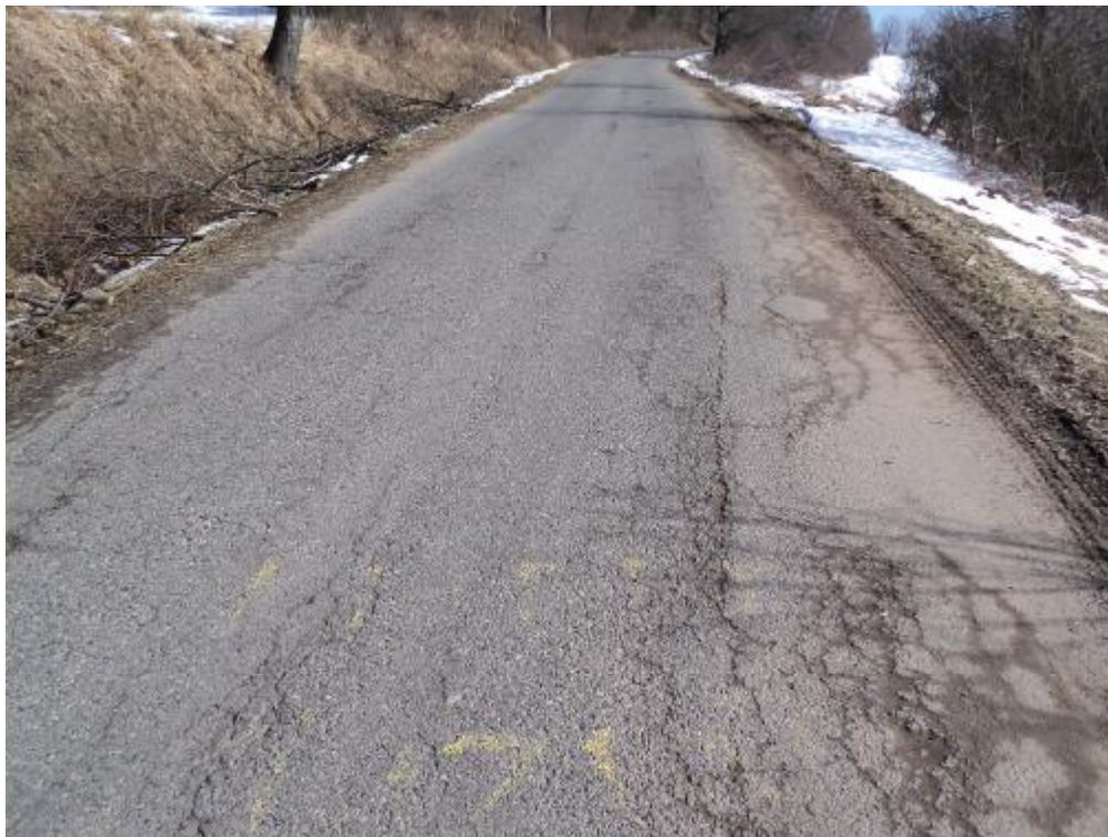
Trhlina rozvětvená podélná, hloubková koroze, síťové trhliny – km 6,100.
