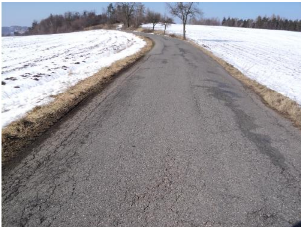
Olamování okrajů vozovky, trhlina rozvětvená podélná – km 6,850.
