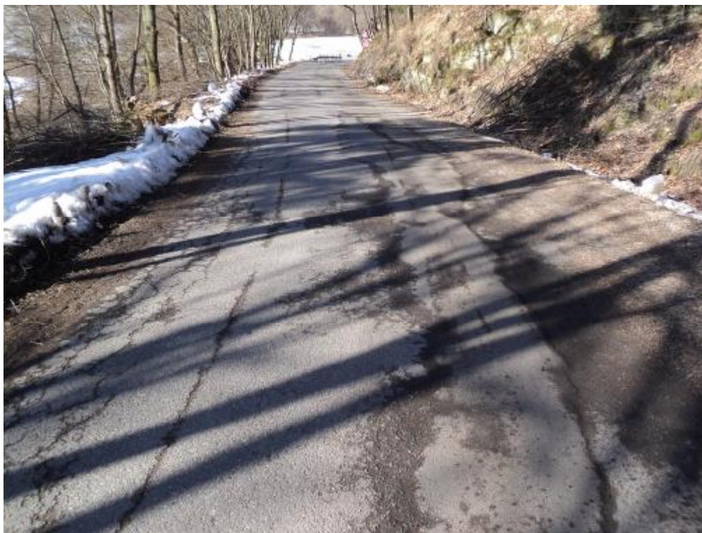
Olamování okrajů vozovky, plošná deformace vozovky – km 2,300.
